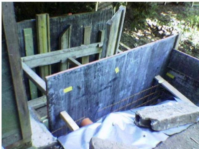
Zeitgleich zum Bau der Hütte wurde der Bau unseres Fischhälterbeckens begonnen. Die Grundplatte wurde schon betoniert, Die Seitenplatten sind eingeschalt. Am 03.09.05 wurden diese betoniert. Hier sind noch die beiden Halterungen für die Schottung aus Holzbohlen für den Stau und eine Gitterabdeckung zu erstellen. Dieses Bauwerk muss bis zu unserem Fischereifest am 08.10.05 fertig gestellt werden.
